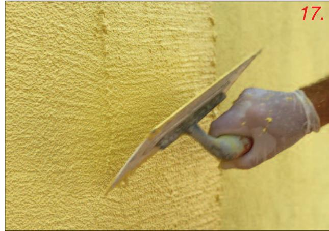
Il sistema Vacunanex Cappotto finito è caratterizzato da movimenti localizzati "dentro-fuori" derivanti dalla natura e composizione stessa del sistema e sono da ritenersi normali se limitati a 2-3mm di rientro. Il ciclo di rasatura superficiale con Rete e Rasante Aquafire è progettato per assecondare tale caratteristica.
