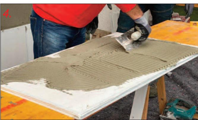
4. Spalmare il Rasante Aquafire® sul pannello con frattazzo dentato da 10mm.
